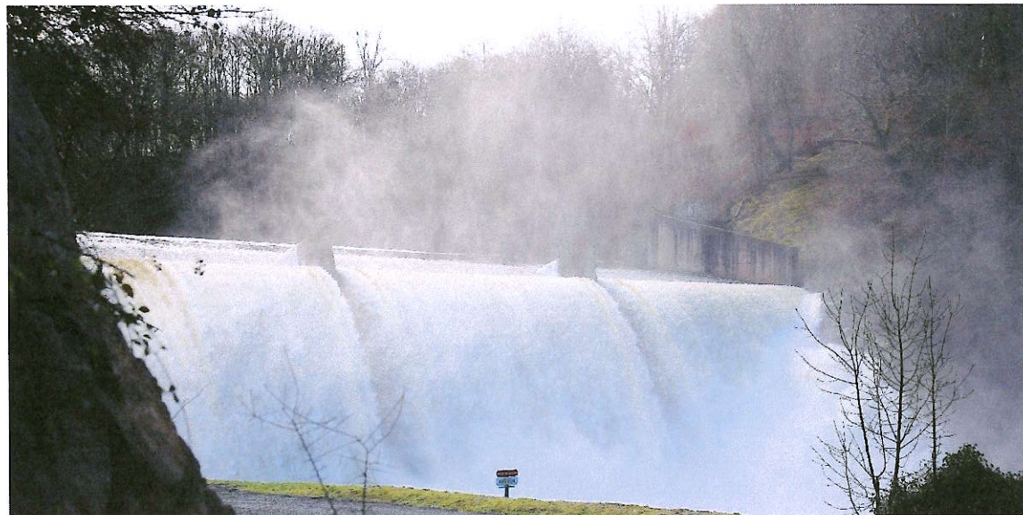
La retenue d'eau de Champsanglard, ici lors d'une période de niveau maximal, deviendra une source d'eau collective. Elle passera par une future station de traitement pour devenir potable puis être renvoyée au besoin vers le nord et le Syndicat de la Vallée de la Creuse, et vers le sud, pour alimenter le Syndicat d'Ahun et, sur le chemin, le territoire de l'Agglomération de Guéret. ARCHIVE MATHIEU TIERAS
